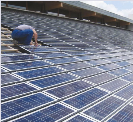
POSE EN INTÉGRATION AU BÂTI
